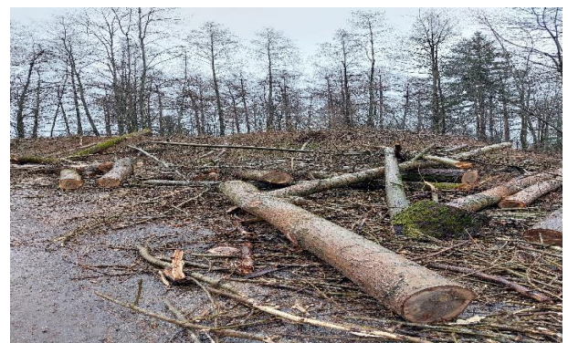
Entnahme von Starkholz zum Schutz vor Sturmschäden an den Randdämmen der Deponie
